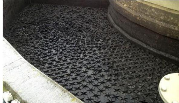
随后将污泥脱水，并将脱出的水进入“Anita Mox®过程”，这个过程最好保持在18℃以上，因此维持污泥在储罐中的温度非常重要。为此，我们安装了海克斯浮盖，以此减少了热损失，维持了储罐温度。使用海克斯浮盖后，Anita Mox®过程的温度从17℃升高到19.7℃（2013年1月到2月测量），虽然空气温度下降到零下15℃。
